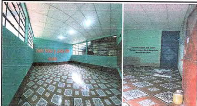
FINALIZACIÓN DE INSTALACIÓN DE CIELO FALSO EN AULAS Y DIRECCIÓN DEL ESTABLECIMIENTO
