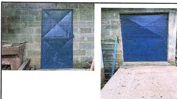
FINALIZACIÓN DE PUERTAS DE METAL INTERIOR Y PRINCIPAL DE LA COCINA.
