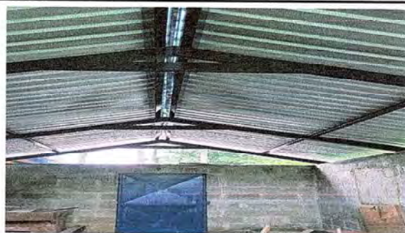
FINALIZACIÓN DEL ENTECHADO DE LA COCINA DEL ESTABLECIMIENTO.
