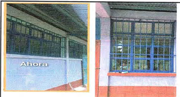
FINALIZACIÓN DE VENTANAS CON BALCONES DE AULAS, DIRECCIÓN Y COCINA DEL ESTABLECIMIENTO
